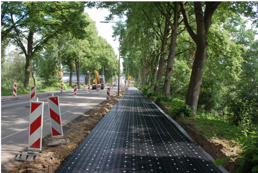
Foto 3. Overzicht ophoging maaiveld met Permavoid
